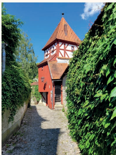
Flurerturm in Beilngries
